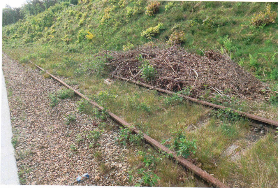
Figuur 1.12 Gekapte bomen tbv de werkzaamheden en grind tot aan spoorlijn.
