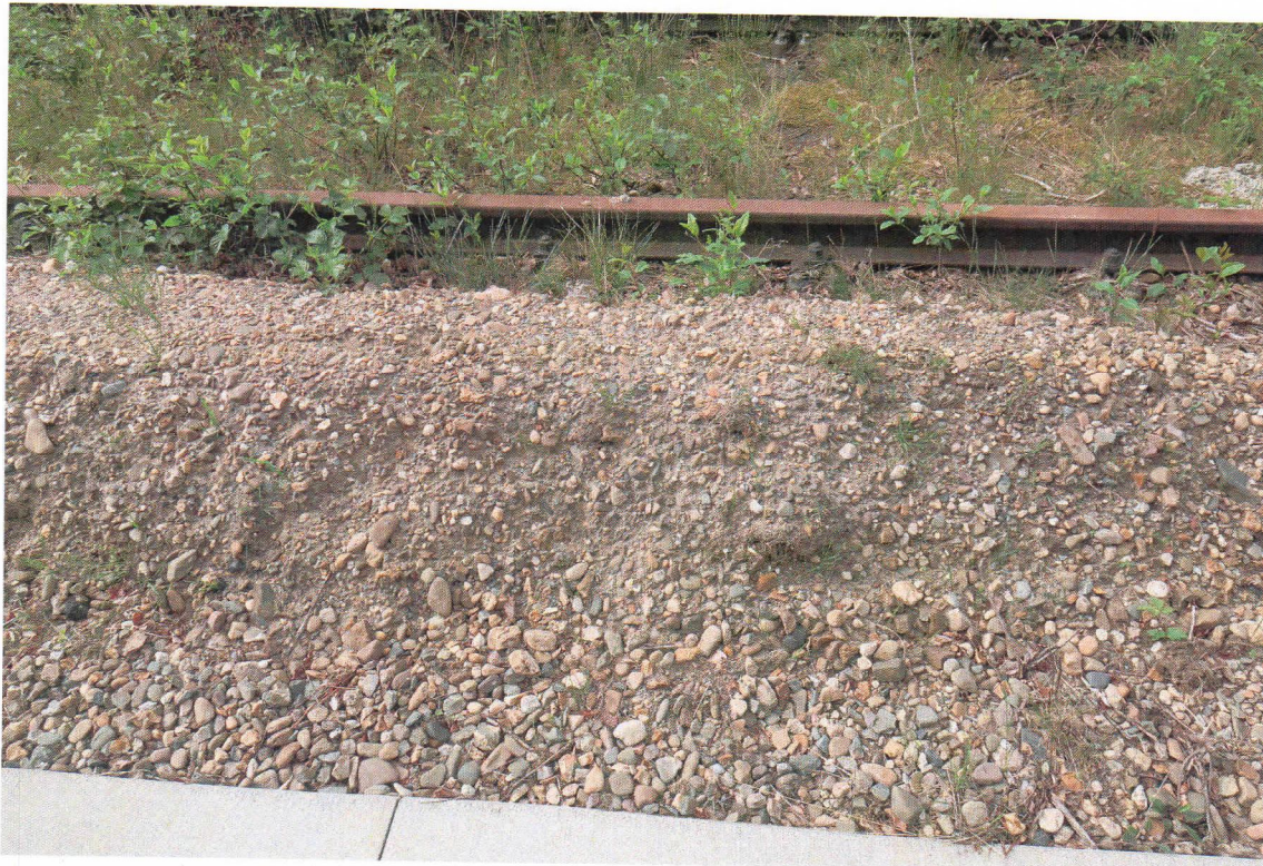
Figuur 1.15 Grindbed loopt tot bijna aan en al over de spoorlijn-bielzen
